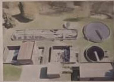
La depurazione delle acque alla Vitale Barberis Canonico
